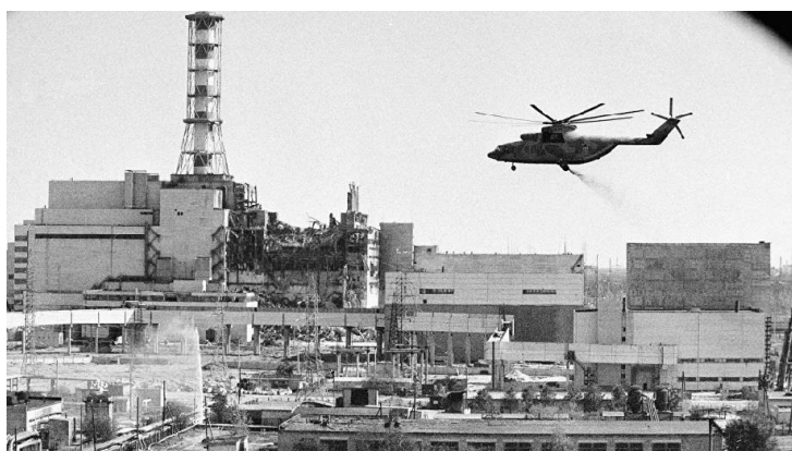
Figura 6 - Helicóptero descontaminando edifícios da usina nuclear de Chernobyl (Ucrânia em 1986).
