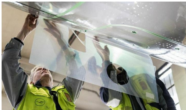
Figura 3 - Aplicação do filme AeroSHARK na fuselagem
